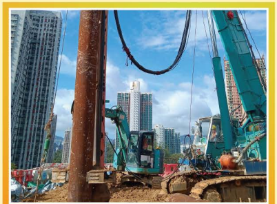
臨時鋼管樁工程 Temporary Pipe Piling
